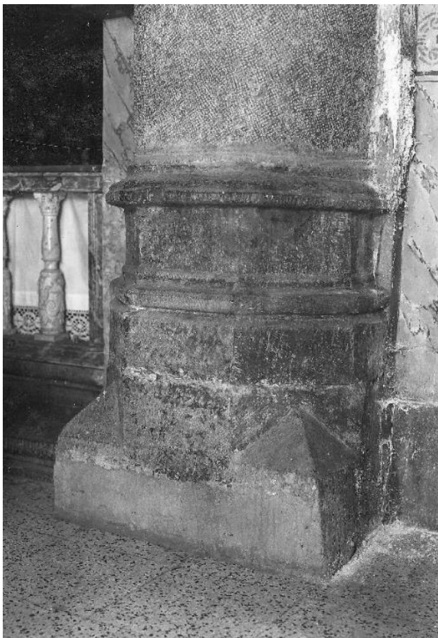
à l'entrée du chœur
